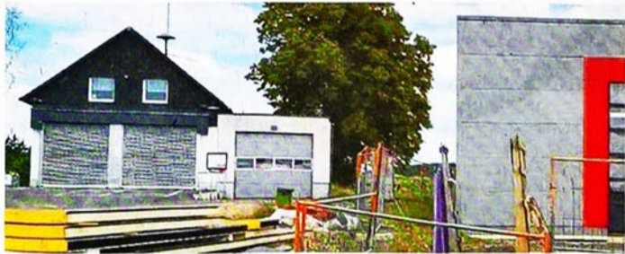
Das alte Gerätehaus von 1965 soll im Frühjahr 2023 abgerissen werden.
