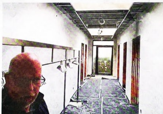
Löschgruppenführer Thomas Felske im hellen und fast fertigen Flurbereich.
